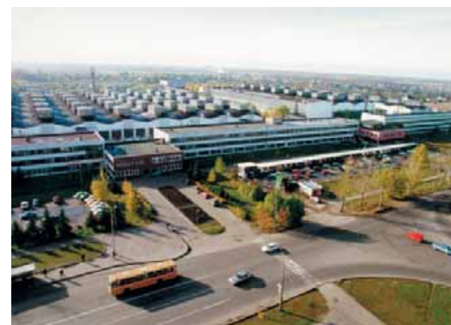
Производственные корпуса Корпорации
